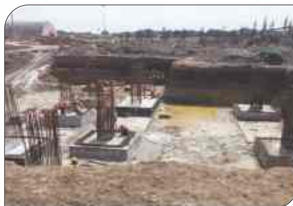
Civil & Strl. Works for U&O (M/s CINDA): HRSG Area foundation footing
